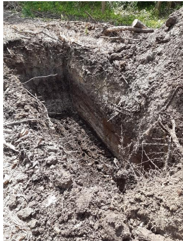
Creusement d'une fosse de 2 à 3 m de profondeur pour enfouissement de la Symphorine blanche
